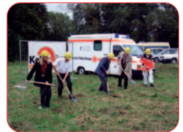
Nach dem Spatenstich dauerte die Fertigstellung der Rettungswache Süßen noch zehn Monate.
