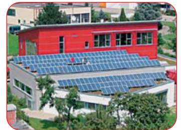
Die neue Solaranlage auf dem Dach der DRK-Bereitschaft Schlierbach.
