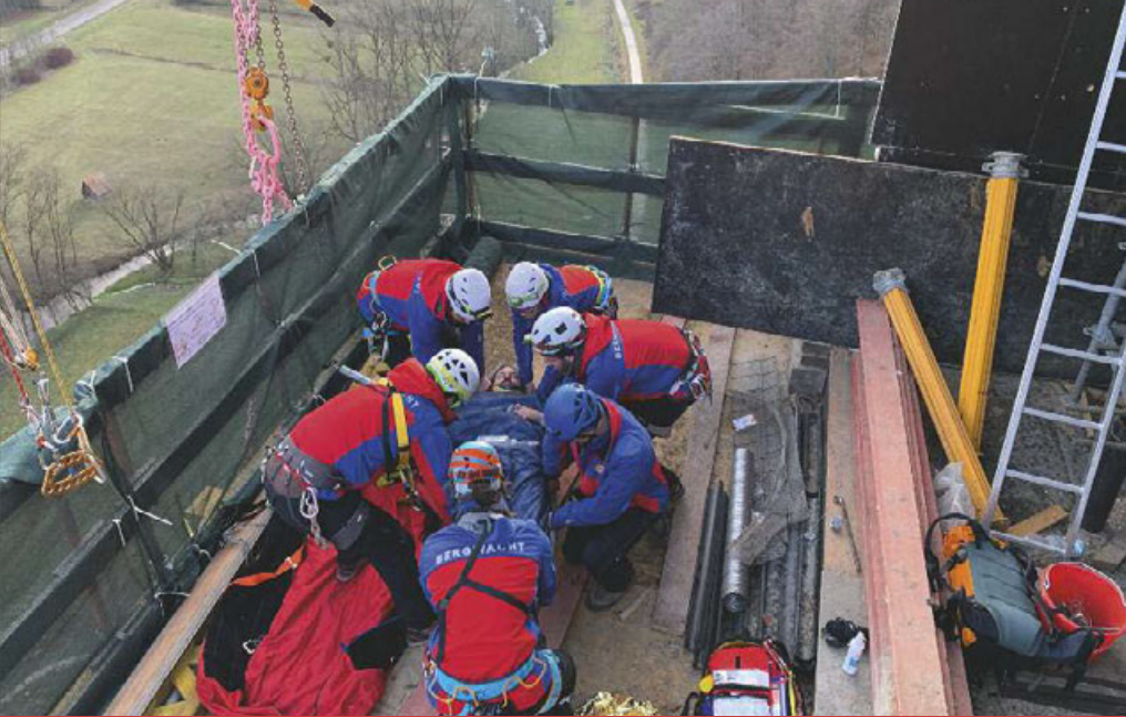
Hauptübung auf einer Arbeitsplattform der Bahnbaustelle bei Mühlhausen im Täle.
