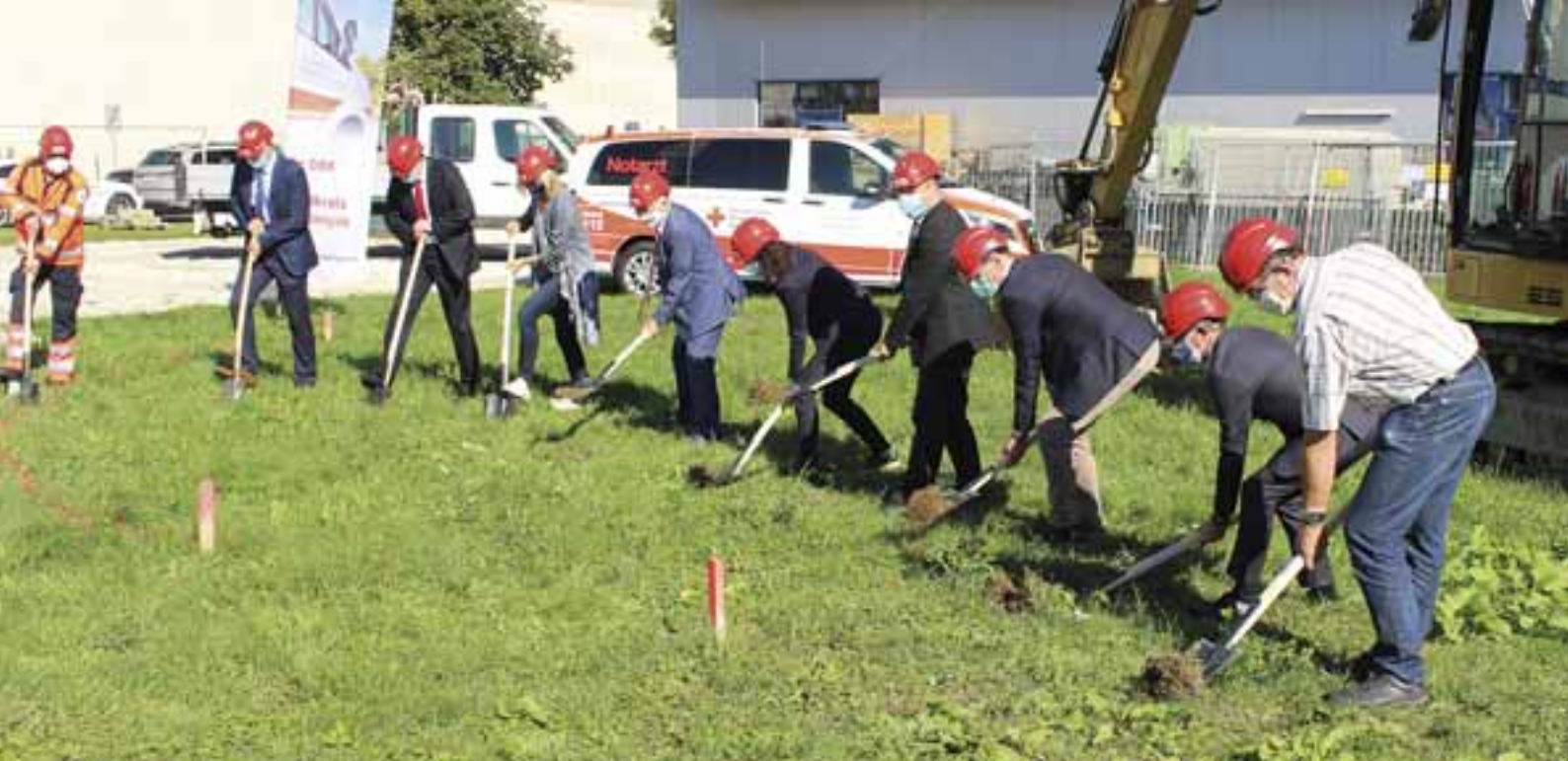
Mit dem symbolischen Spatenstich am 8. September 2020 wurde der weitere Ausbau der Rettungswache Süßen auf den Weg gebracht.
